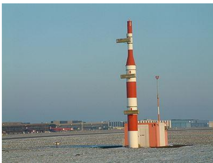
Рисунок 1.2 – Конструкція гліссадного радіомаяка в аеропорту Гановера
