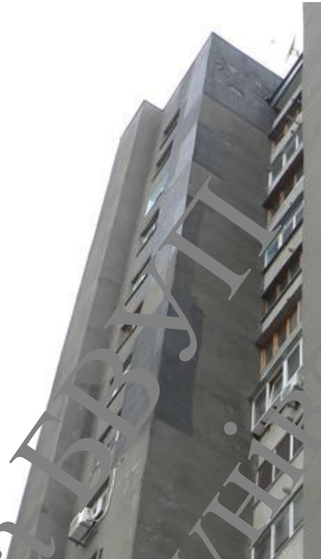
Рисунок 2.5 - Герметизація зовнішньої поверхні стін ідрозольюючими паронепроникними матеріалами
