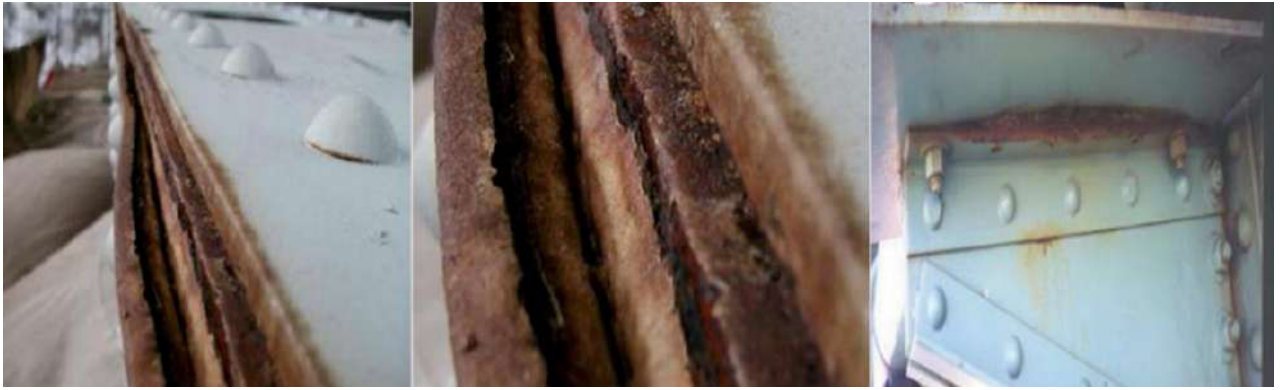
Рисунок 1.6 – Розшарування металу деталей фюзеляжу
