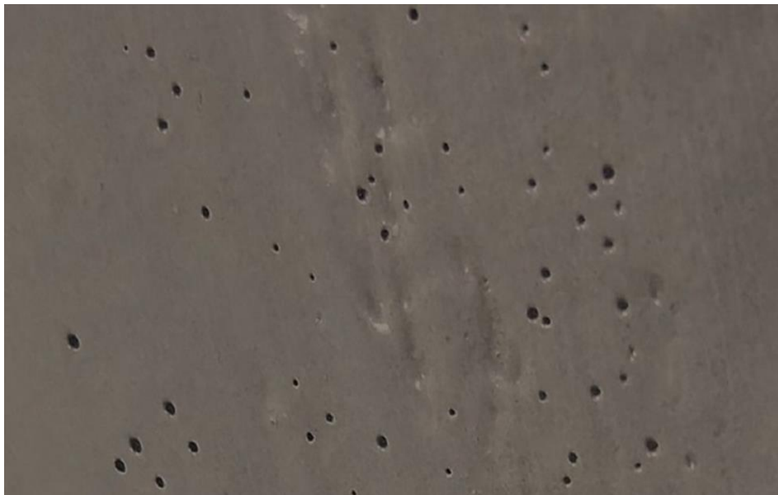
Рисунок 2.5 – Дефекти голчастого типу у порошковому покритті
